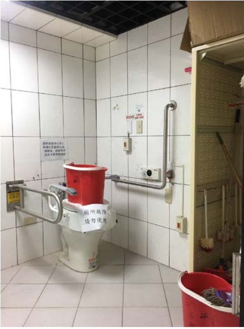
照片取自勞動部勞動力發展署桃竹苗分署無障礙廁所拍攝
